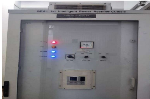
Gambar 3. Rectifier Cubicle
